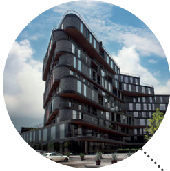
IKONICKÁ BUDOVA ICONIC BUILDING
