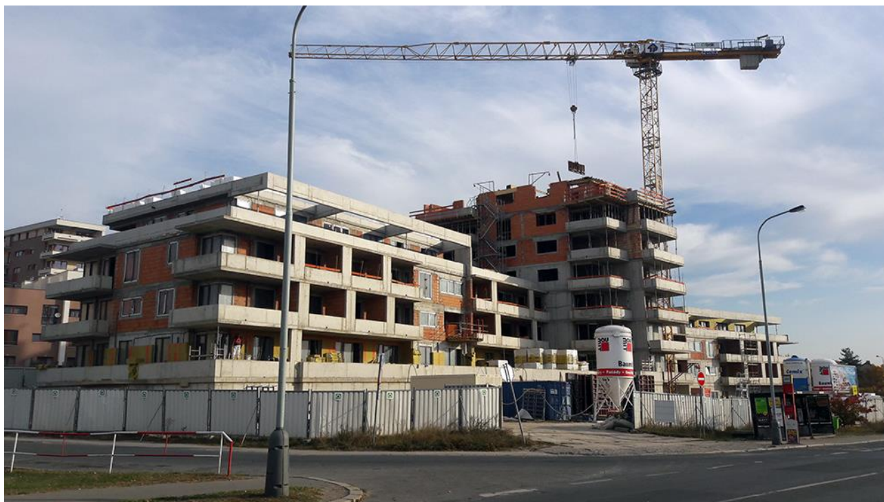
Hrubá stavba bytového domu E, který bude dokončen v září 2019
