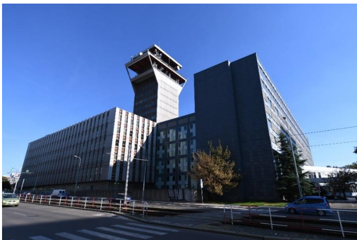
Současná nefunkční telekomunikační budova
