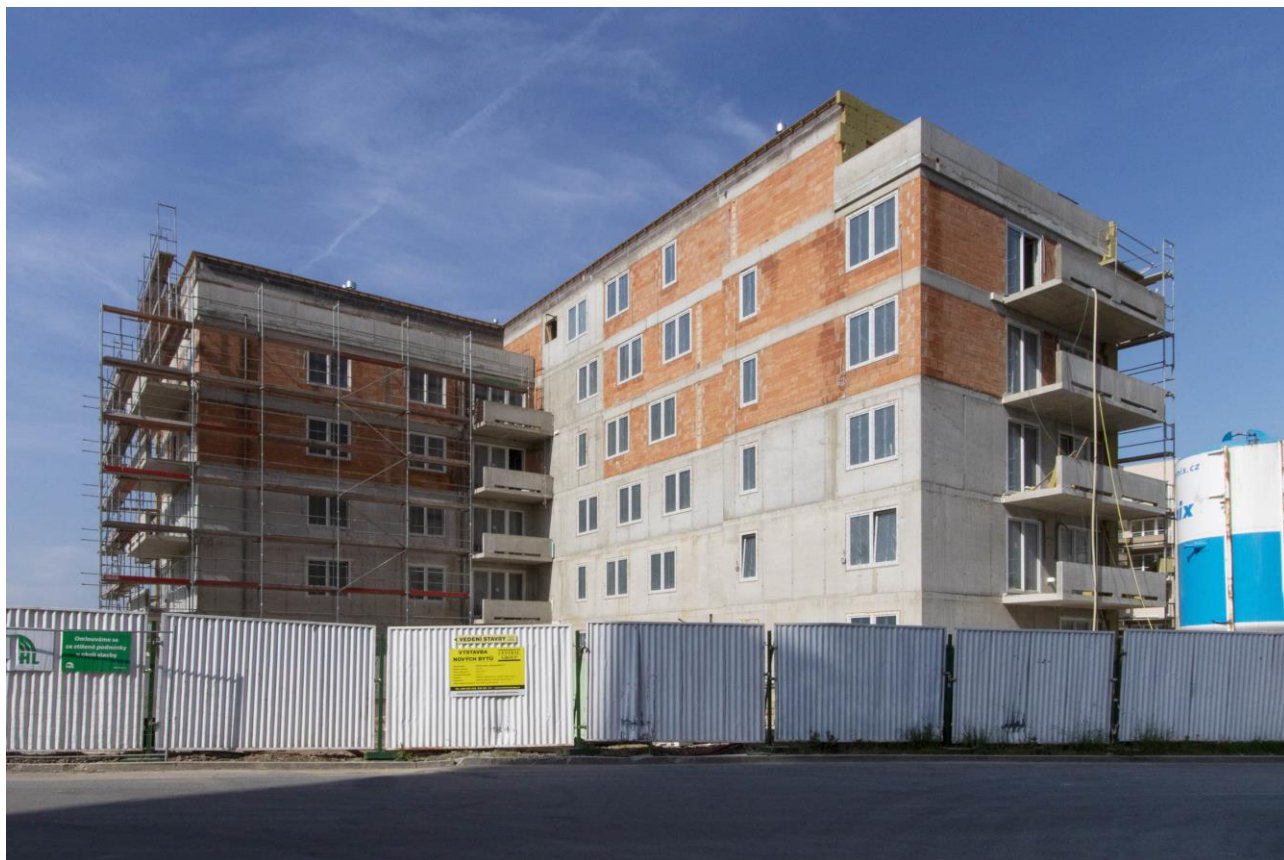
Hrubá stavba bytového domu C projektu Javorová čtvrť II.
