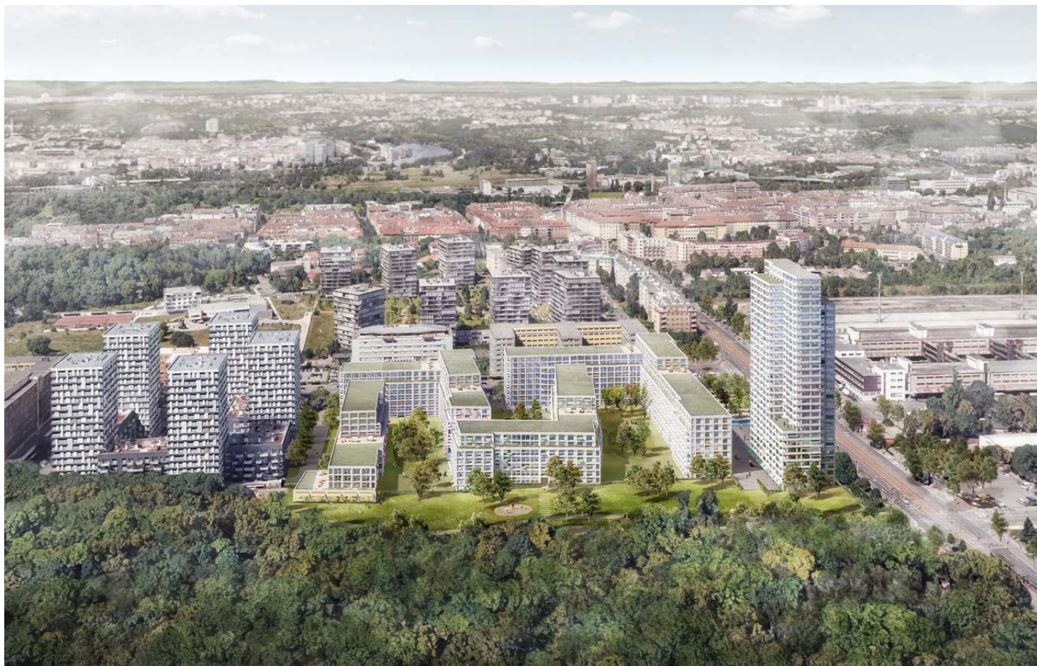
Plať pohled z jihu: zahradní strana obytného souboru
