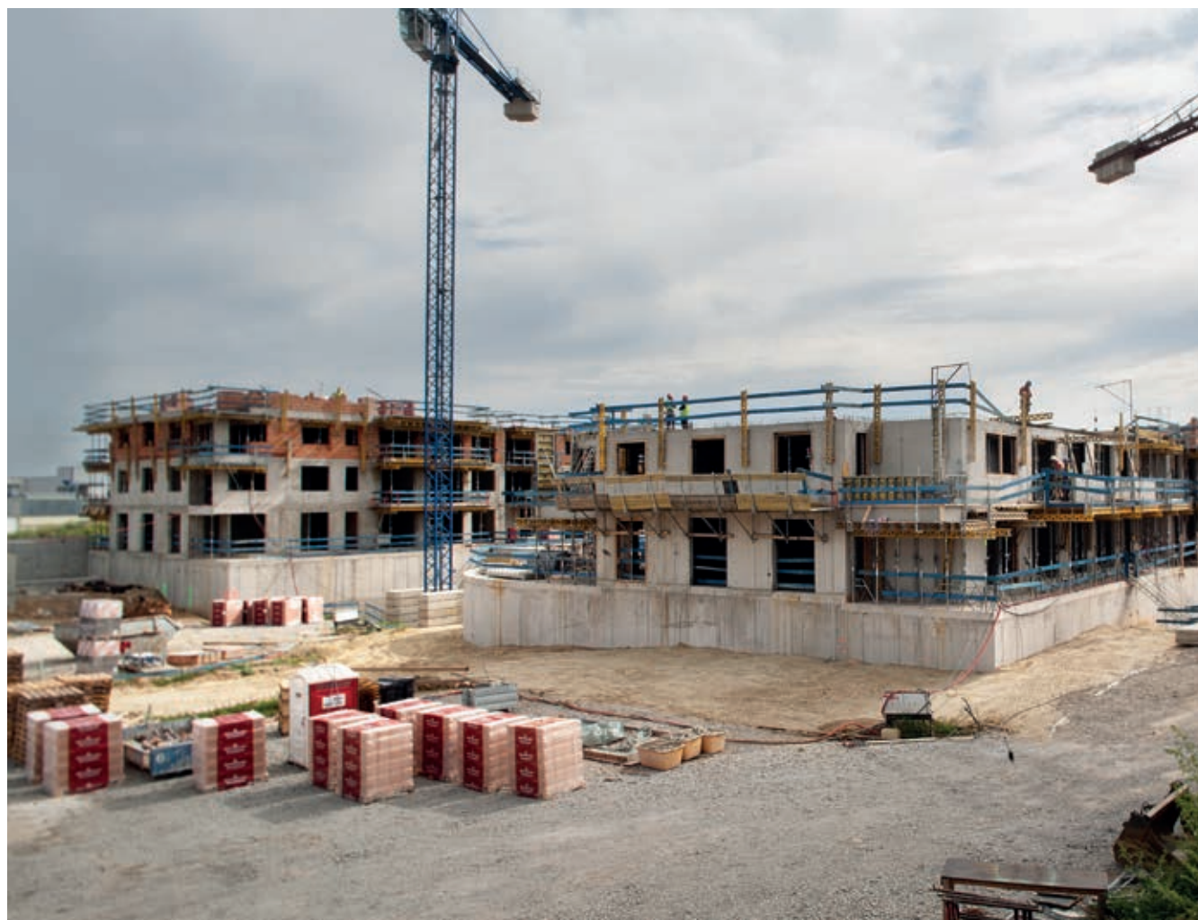
Realizace hrubé stavby, vlevo objekt E, vpravo objekt D
