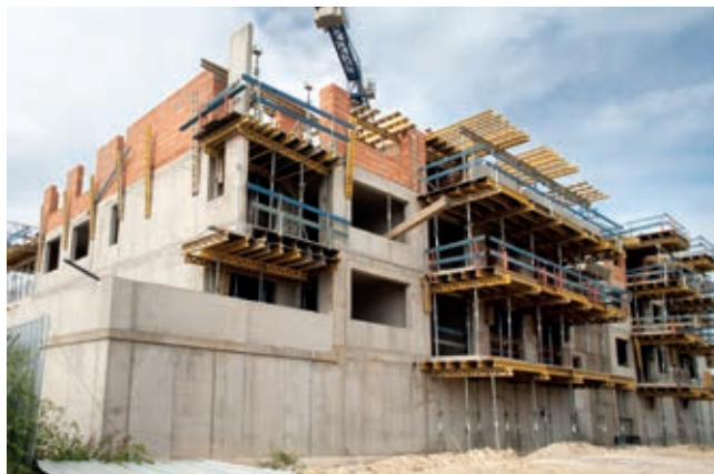
Realizace hrubé stavby 3. NP, objekt E, jihozápadní pohled
